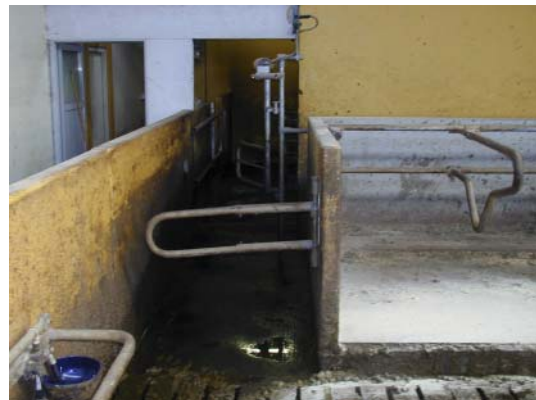
Figur 6.12. Køerne kan berøre rammen ved drikkekopperne og svingbøjlen ind til malkecenteret samtidigt. De to inventardele er ikke indbyrdes forbundet med supplerende udligningsforbindelser. Imidlertid er de begge via væggen i forbindelse med det armerede og - dermed via udligningsforbindelsen - jordforbundne gulv. Det er derfor ikke forbundet med nogen risiko at berøre de to inventardele samtidigt.
