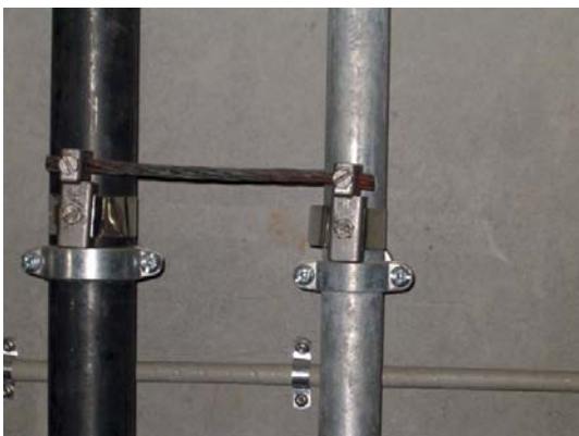
Figur 6.7. Supplerende udligningsforbindelser mellem to rørføringer.
