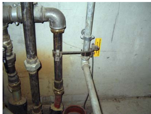
Figur 6.8. Supplerende udligningsforbindelser mellem to rørføringer.
