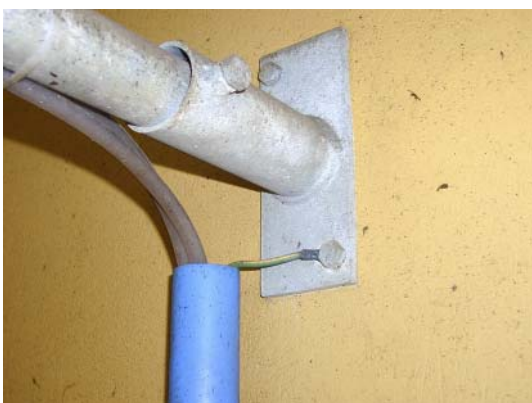
Figur 6.5. En udligningsforbindelse på rørdele til en malkeboks.
